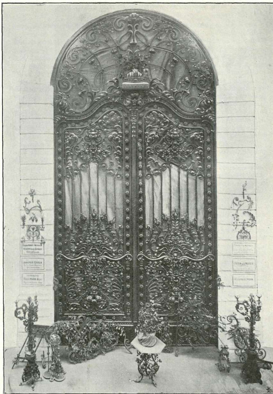
A BUDAI KIRÁLYI VÁR RÁCSOS KAPUJA. TERVEZTE HAUZSMANN ALAJOS MŰEGYETEMI TANÁR. KÉSZÍTETTE JUNGFER GYULA CSÁSZ ÉS KIR. UDVARI MŰLAKATOS. Magassága 8500 mm, szélessége 4000 mm. Kiállította a XI. csoport magyar osztályában, a marsmezei palotában.
