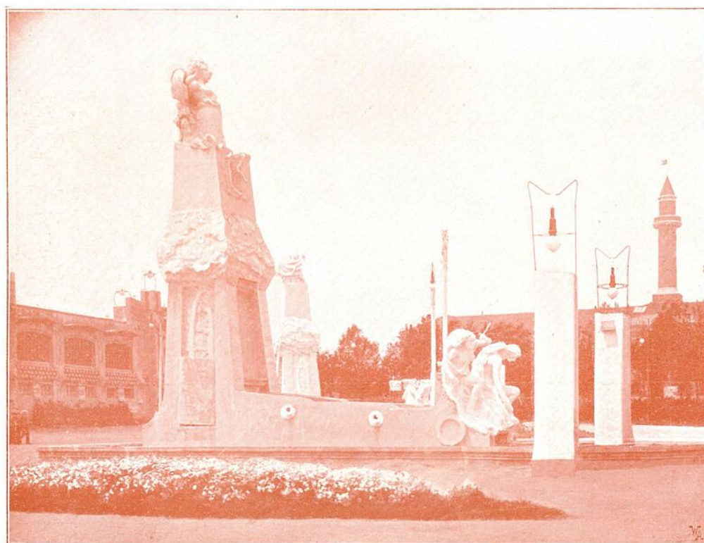
SZÖKÓKÚT A NAGY CSARNOK FŐBEJÁRATA ELŐTT.
