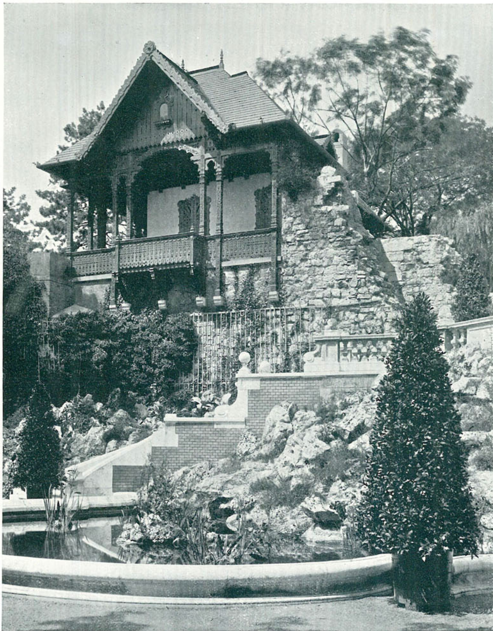
A KERTI HÁZ DUNAFELŐLI HOMLOKZATA.
