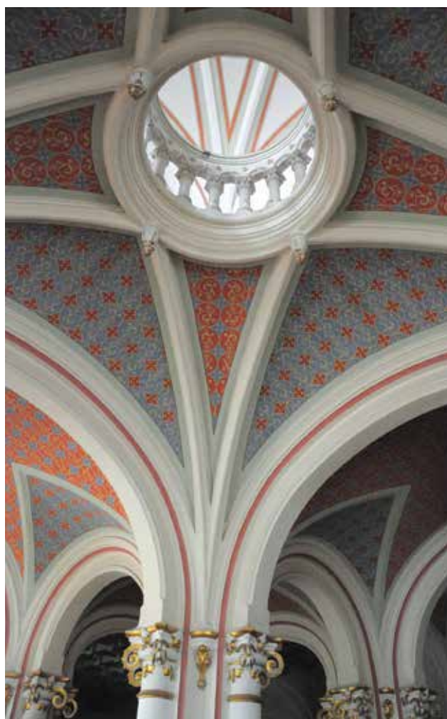
A kecskeméti városháza emeleti előcsarnokának födémáttörése Opening in the ceiling of the upstairs vestibule of the Kecskemét town hall Fotó: Mester Éva
