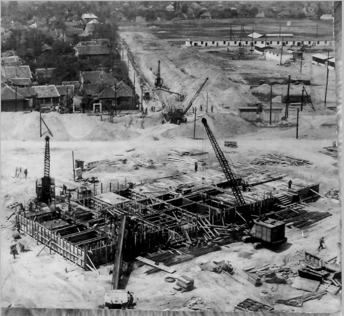
1970. április Nyírpalota utca 12-14.(4-es jelű épület)
