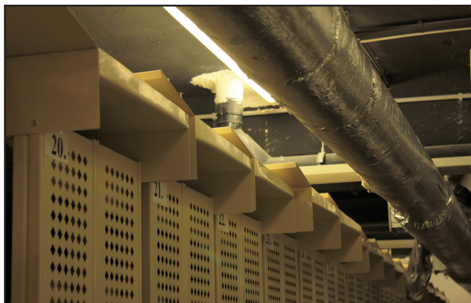
Vízvezető tálcarendszer a tömörraktári polcok fölött
