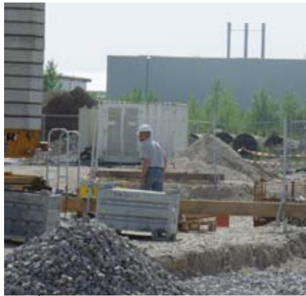
Biodizel-finomító építése Ennsben
