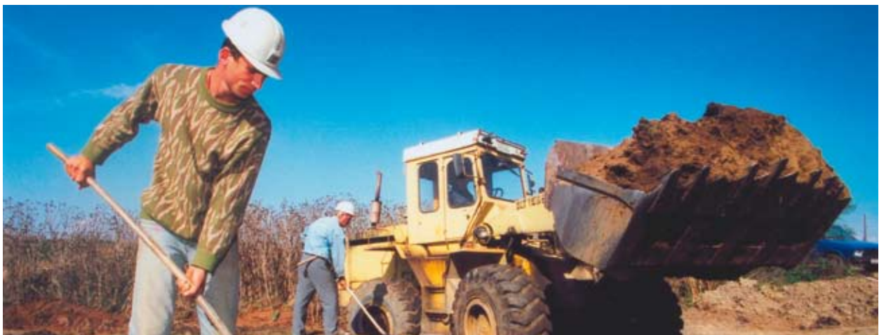
Útépítési munkák Macedónia Volt Jugoszláv Köztársaságban.
