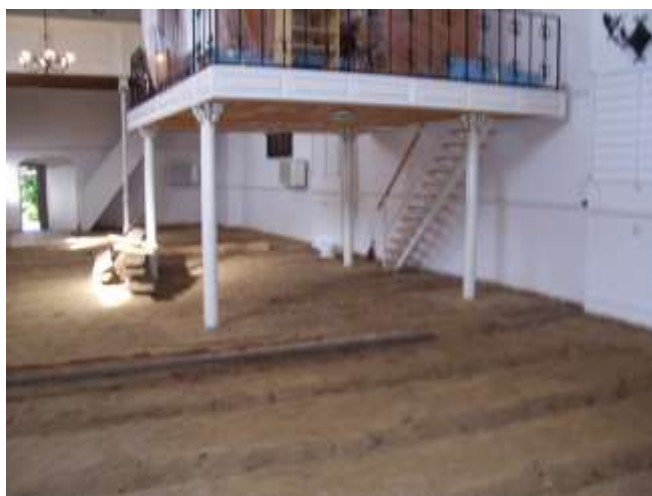
Külső és belső felújítások az ezredfordulón.
