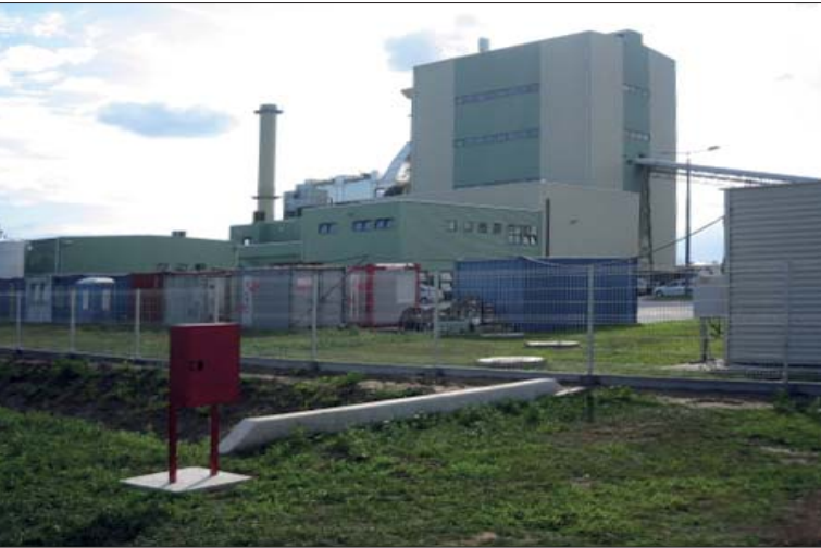
Centrale di energia verde a Szakoly
