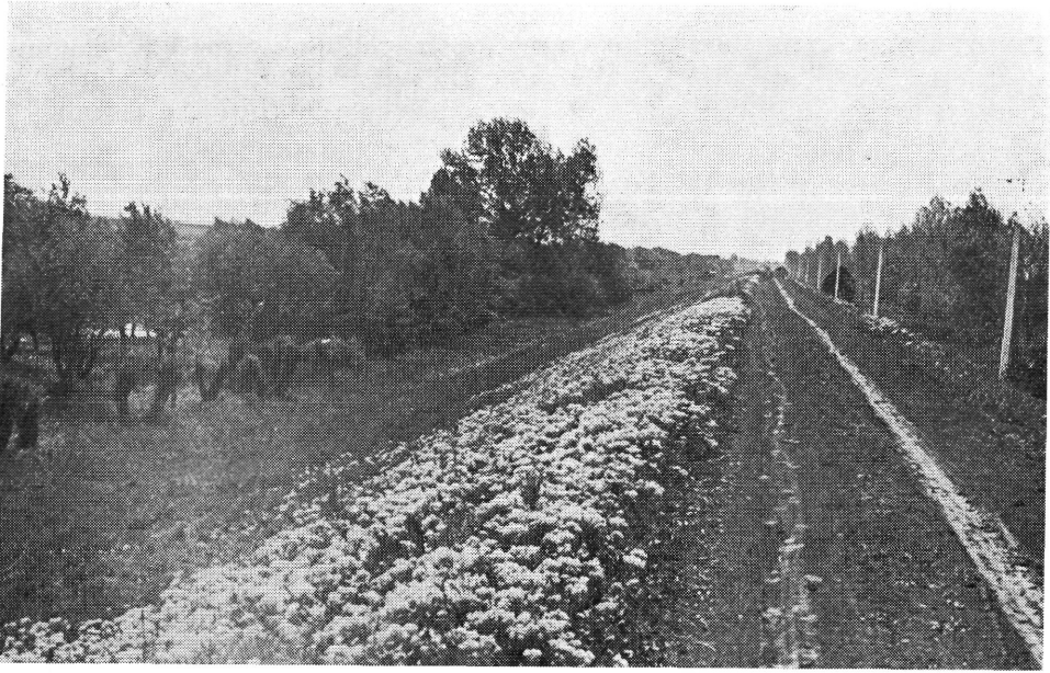
5. ábra. A Sebes-Körös gátja Körösladánytól nyugatra. Balra ártéri füzes kubikgödörökben, 1959. Abb. 5. Damm des Sebes-Körös westlich von Körösladány. Links Weiden in den von Dammbauarbeiten zurückgebliebenen Gruben, 1959
