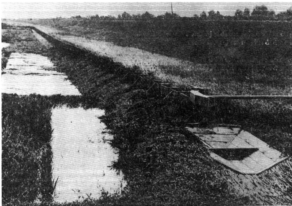
13. kép. Az Endrőd-kocsorhegyi minta-öntözőtelep részlete. A nyomócső facsatornába és csillapító-aknás földcsatornába juttatja a vizet. Fotó: Oroszlány I., 1940.
