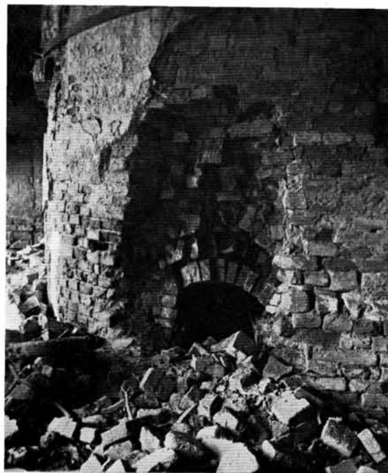
F) Az „A”/IV. sz. épület körkemencéjének tűzelőnyílása. F) Feueröffnung des Rundofens im „A”/IV. Bau. F) Porte du foyer du four circulaire du bâtiment «A»/IV. F) Топка кольцевой печи в здании «A»/IV.
