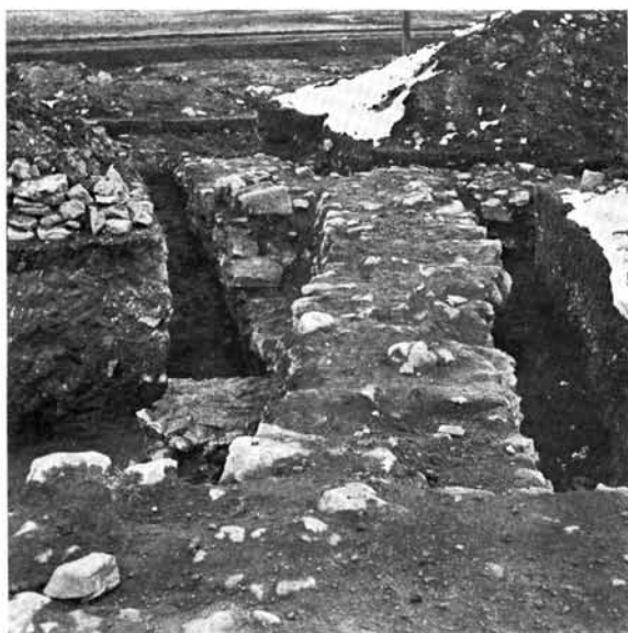
9. Északi épület. A korábbi ház falára alapozott első helyiség fala. 9. Das nördliche Gebäude. Die Mauer des auf die Südmauer des früheren Gebäudes fundierten ersten Raumes. 9. Bâtiment nord. Le mur du premier local, élevé sur le mur sud de l'ancienne maison. 9. Северное здание. Стена первого помещения, базированная на южную стену более раннего дома.
