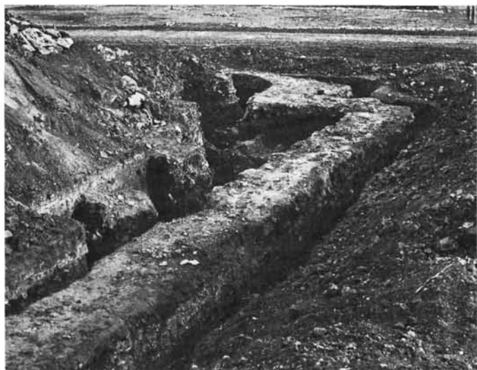
5. A templom déli fala a cölöpalapokkal, feltárás közben. 5. Die Südmauer der Kirche mit der Pfahlgründung während der Freilegung. 5. Partie sud de l'église, avec les palées, pendant la mise à jour. 5. Южная стена церкви, основания свай при раскопках.
