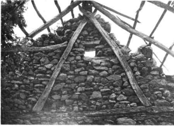
7. ábra. Kőfalú, kőoromfalú öreg, elhagyott pince, ollószáras szelemene és tetőszerkezete belülről. Kakasülő a kőfalban. Szöllősi oldal.
