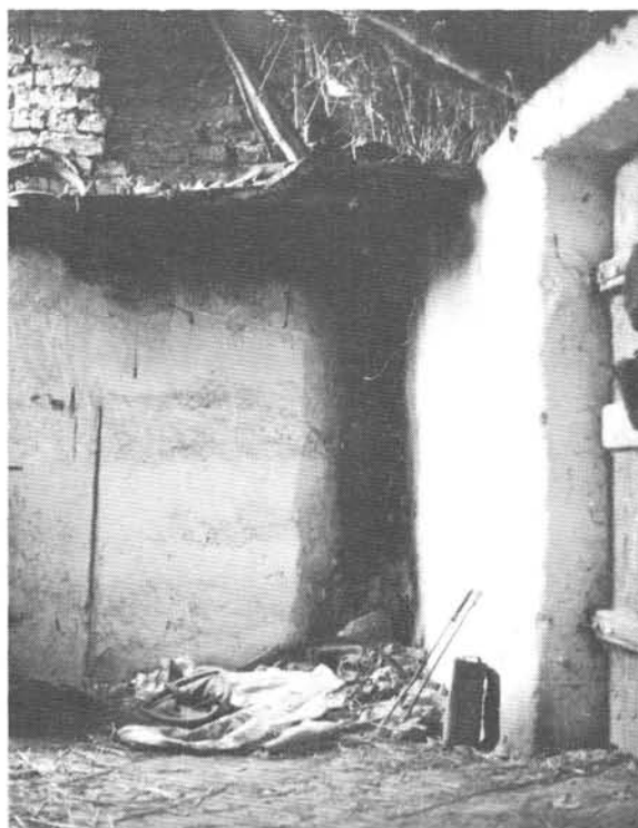
14. ábra. Szabadtűzhely a külső, padlásolatlan pincerész sarkában, deszka szikrafogóval. Dobai oldal 260. számú pincéje.
