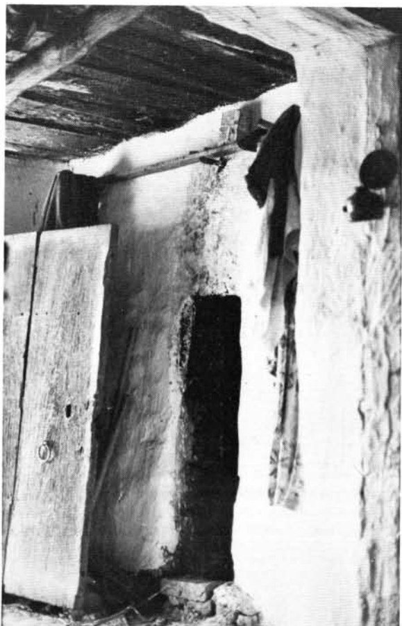
15. ábra. Vályogfalba rakott szabadtüzhely, felette deszka szikrafogó. Vásárhelyi oldal Pados-féle pince.
