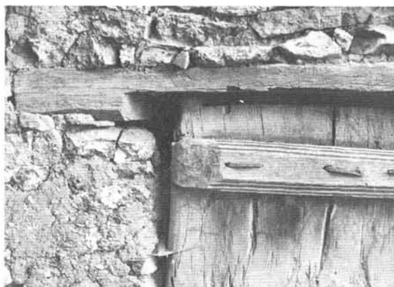
13. ábra. Pinceajtó fatengelye és kereszt erősítő fapántjának hornyolt diszitése.
