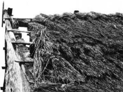
9. ábra. A fedélfák facsapos rögzítése, a zsúptető szegése és a kettős zsúpgicák. Dobai oldal 260. számú Búzás-féle pincéje.
