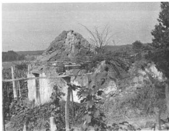
4. ábra. Vályogfalú, vályogoromfalú, kétosztatú rom-pince. Az oromfal vályogtéglaí középen és az oromfal két szélén, a fal síkjára merőlegesen rakottak. Jenei oldal.
