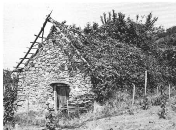
5. ábra. Elhagyott kőpince homlokzata és tetőszerkezete a szőlősi oldalon.
