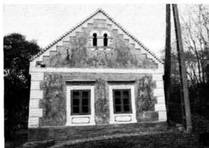
36. ábra. Rozettás szalagkeretes vakolatdisz, Cséri Flórián háza, Mindszentkál (lakatlan) Abb. 36. Mörtelzierde der Giebelmauer bei Flórián Cséri, heute nichtmehr bewohnt, Mindszentkál, Jókai Strasse 9. 37. ábra. Eklektikus jellegű vakolatdiszes utcai homlokzat, Kékkút, Fő u. 57. Mohos-ház Abb. 37. Eklektische Mörtelzierde in Kékkút am Mohos-Haus, Fő Str. 57. 38. ábra. Mellvédés harántboltíves lopott tornác, Balatonhenye, Kütyü Abb. 38. Flur mit Quergurtbogen und Parapet, Balatonhenye, Kütyü
