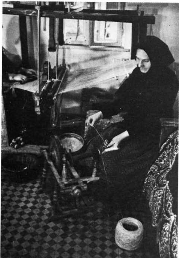
11. kép: Csévetöltés csévöllös rokkával.
