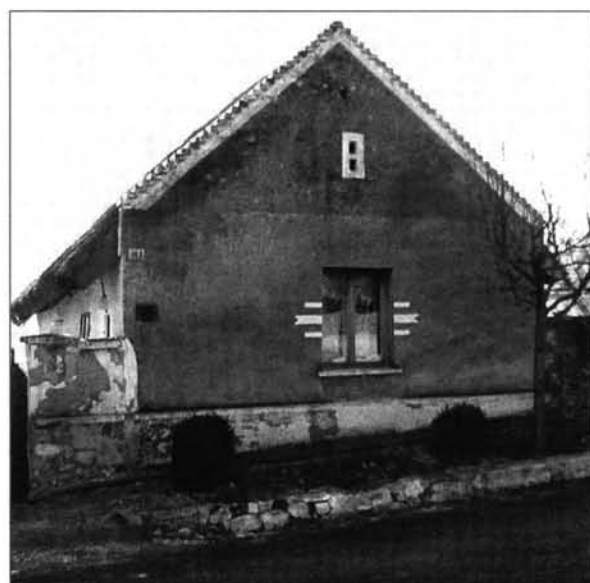
13. kép: A ház homlokzata (fotó: Petánovics Katalin)
