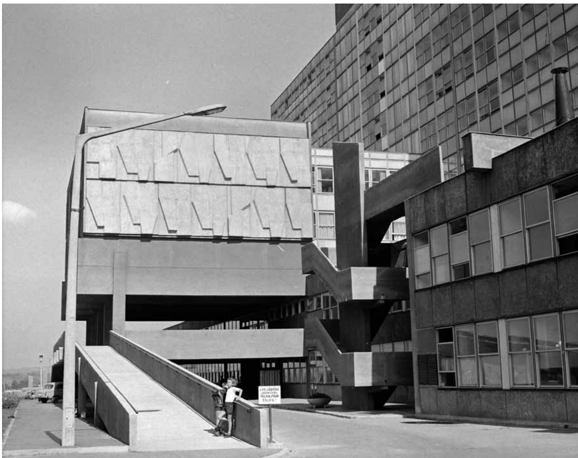
15. Illés Gyula: Betonplasztika , Városi kórház, Kazincbarcika, 1967 ©Fortepan / 100929 / Erdei Katalin archívuma
