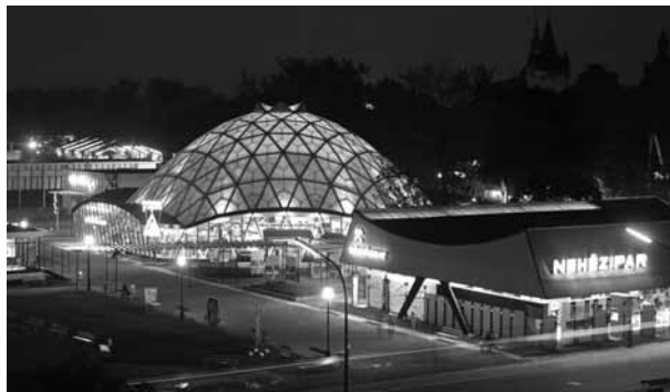
19. Kádár István–Ozorai Imre: A Budapesti Ipari Vásár alumínium- és vegyipari pavilonja alumínium rudakból összeállított, kupolaszerű szerkezettel, Budapest (Városliget), 1961 MTI Fotóarchívum, FGOBA19630519004
