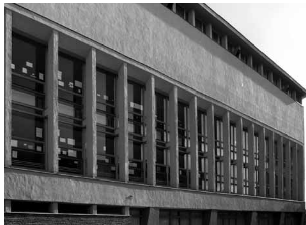
11. A Révai Gimnázium bővítése, nyugati homlokzat, Győr, 2015 A szerző fotója
