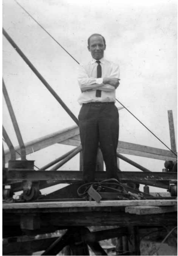
22. Pilt Rudolf a győri Székesegyház épülő toronysisakjának állványzatán, 1968 körül Pilt Rudolf hagyatéka (magántulajdon)
