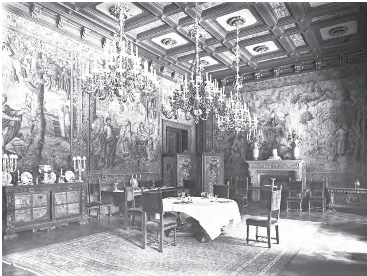
12. A földszinti ebédlőterem Budapest, Magyar Építészeti Múzeum és Műemlékvédelmi Dokumentációs Központ, Fotótár
