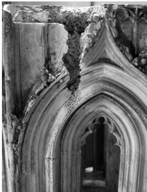
2. A csöpögő víz hatására kimosódott rész (Fotó: Módy Péter)
