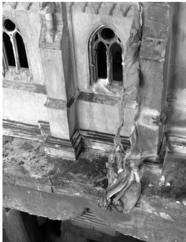
5. A vékony, rugalmas réteggént lehúzható tisztító paszta az északi oldal egyik támpillérén (Fotó: Módy Péter)
