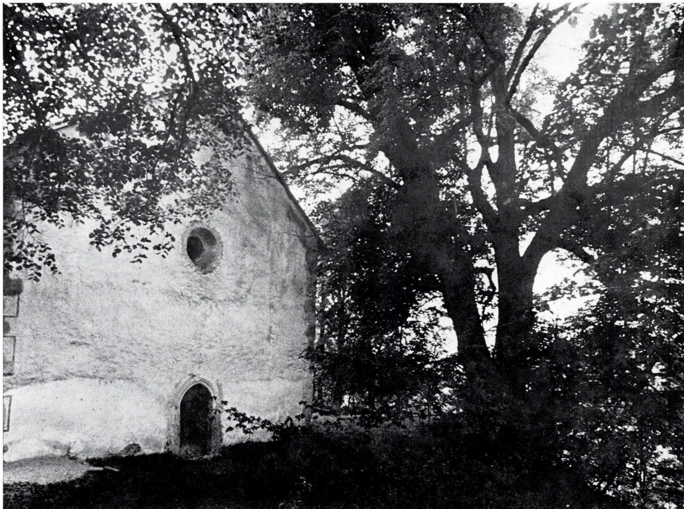
18. Felsőmicsinye (Horná Mičina) a templom nyugati homlokzata (Fotó: Schopper)
