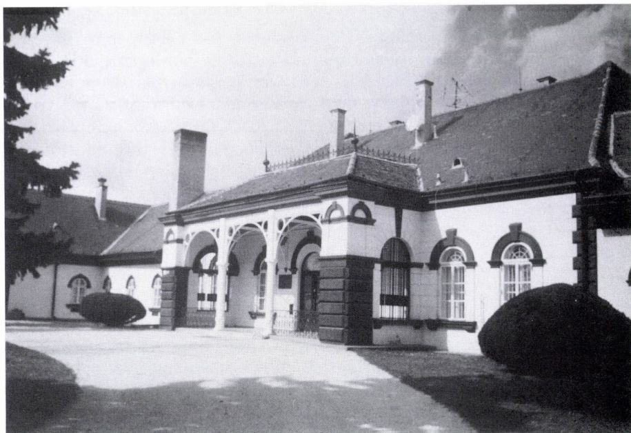
11. Kocsóc, Rakovszky-kastély, jelenlegi állapot, udvari homlokzat
