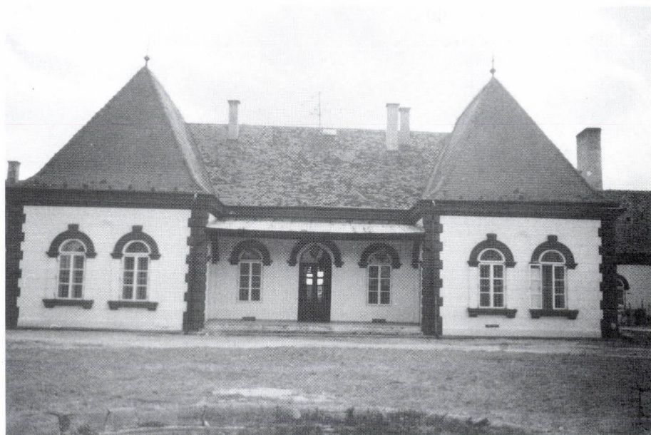
12. Kocsóc, Rakovszky-kastély, jelenlegi állapot, kerti homlokzat
