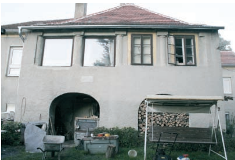
3. kép. A lakóház kerti homlokzatának középső részlete (B. Benkhard Lilla felvétele, 2011).
