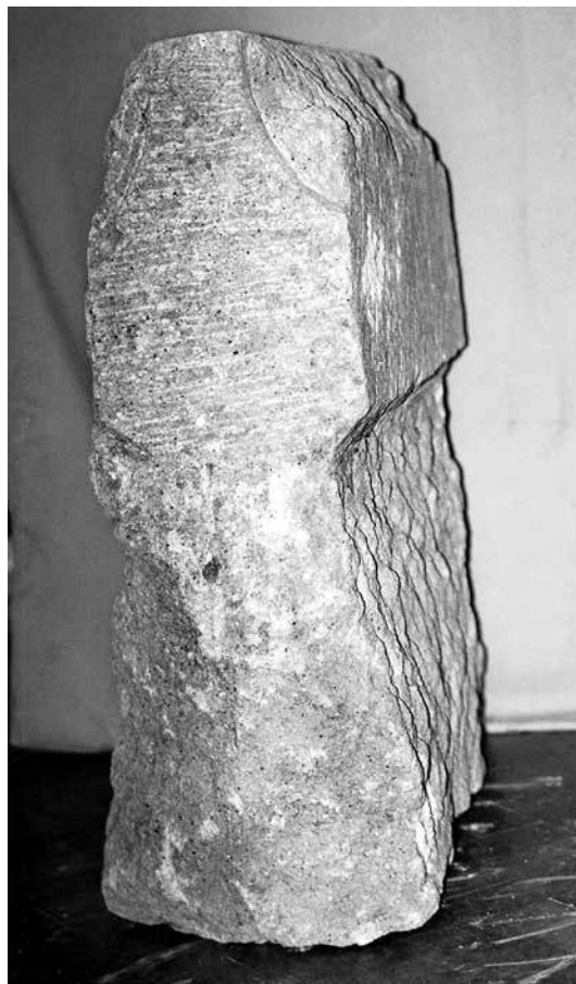
10. kép. Jászágó, Helytörténeti Gyűjtemény. Ágó falu föltárt templomából származó, nem teljesen kifaragott boltózat bordaszakasza. A szerző felvétele
