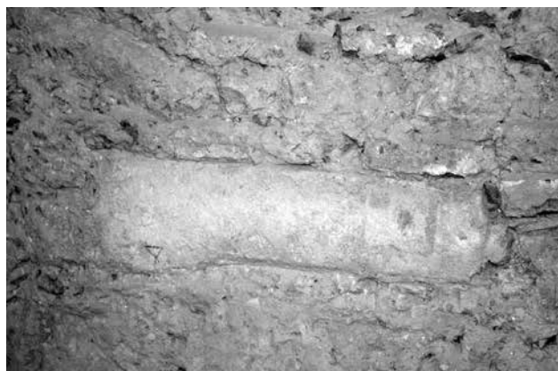
7. kép. Tiszasüly, r. k. templom. Élszedett profilú, gótikus nyíláskeret köeleme a barokk sekrestye falzatában. A szerző felvétele
