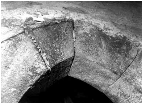
11. kép. Jászapáti, r. k. templom. Gótikus ablak csúcsíves záradéka kőfaragójelekkel a barokk templom déli tornyában. A szerző felvétele
