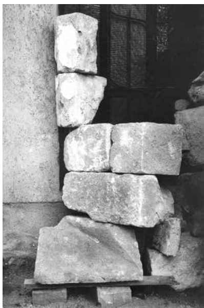
3. kép. Jánoshida, r. k. templom. A középkori ablakok kibontott keret- köelemeinek összeállítása, felületükön kora barokk átfaragás- és meszelés- nyomok is látszanak. A szerző felvétele
