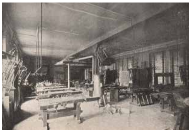
5. A faipari műhely a Népszínház utcai épületben. Kép forrása: HEGEDÜS 1896 (ld. 2. j.)
