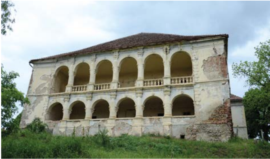
3. A felső kastély déli homlokzata Fotó © Ileana Burnichioiu, 2014
