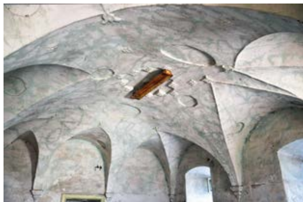
9. Stukkódíszes, boltozott helyiség a kastély földszintjén Fotó © Pakó László, 2022
