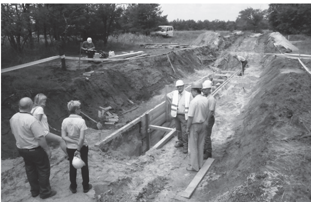
2. ábra. A Pa-21-II árok mélyítésének negyedik szakasza a harmadik mélységi fogással. A második szint már támfallal biztosított
