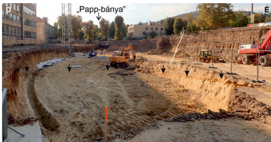
7. ábra. A PTE orvosi kar új épületének alapozása 2018 októberében. A nyilak egy réteg lefutását jelölik.
