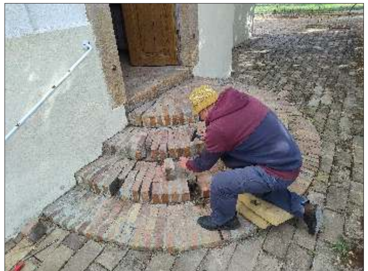
Róbert a templom lépcső javítása közben.
