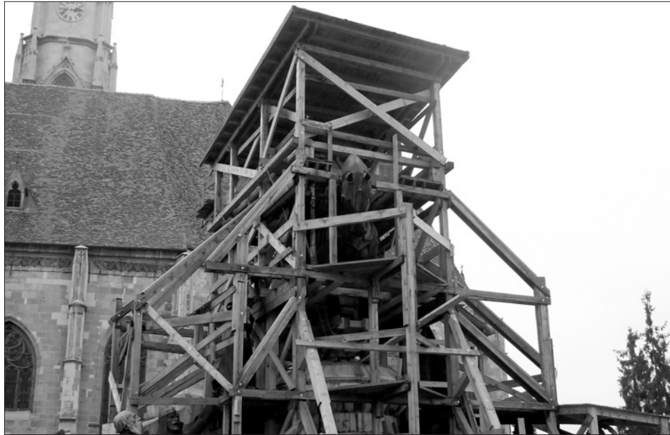
Jelenleg a szobor elemeit egymáshoz rögzítő csavarokat cserélik ki rozsdamentes acélsavarokra
