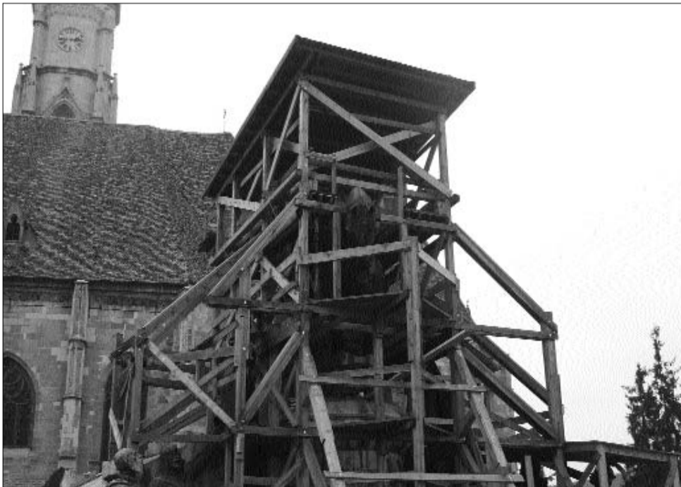
Az ókori falmaradványok felszínre kerülése miatt álltak le a felújítási munkálatok
