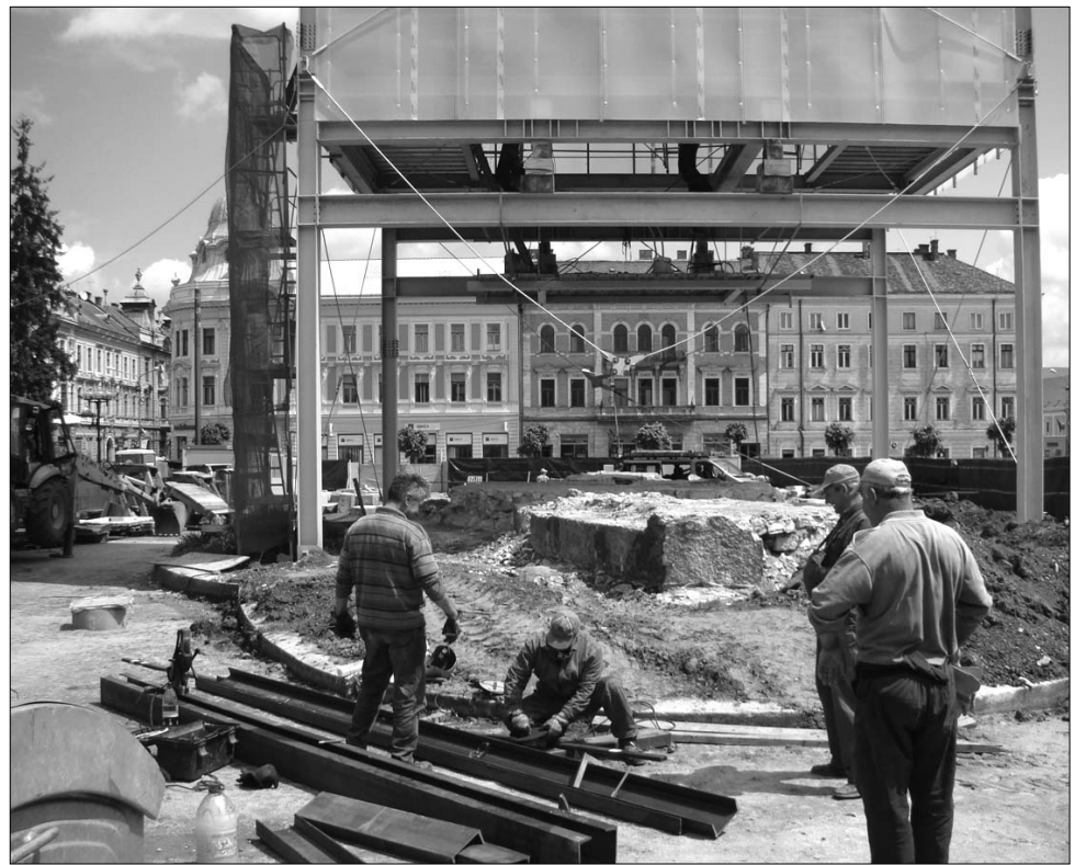
Míg a „burokban” a bronz elemeket újítják, addig a kőtalapzaton is folynak a munkálatok
