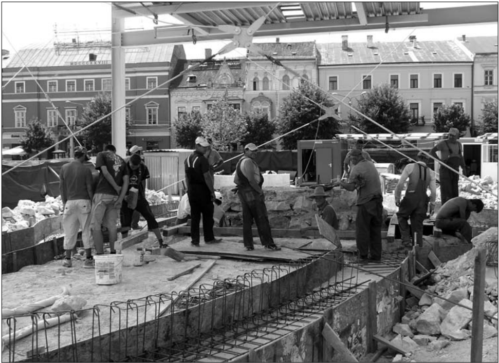
Megöntötték a szoborcsoport betonmagjának egy részét, a talapzat munkálatait jövő héten véglegesítik
