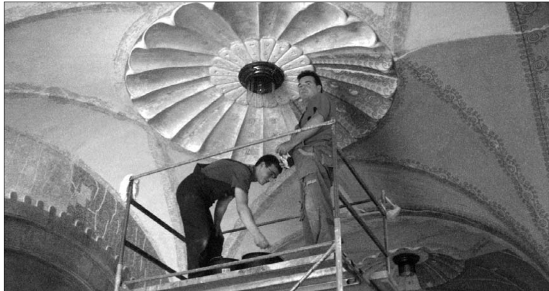
Nemrég hozzákezdtek a marosvásárhelyi városháza előcsarnoka falfelületének felújításához is
