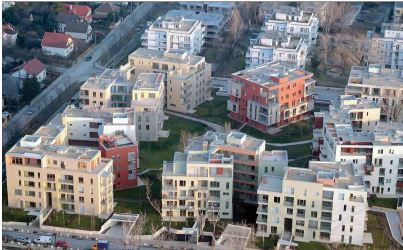
Bár korábban szédítő csúcsra jutott a magasépítésben, a megafejlesztő újabban a mélyépítésben gondolkodik
