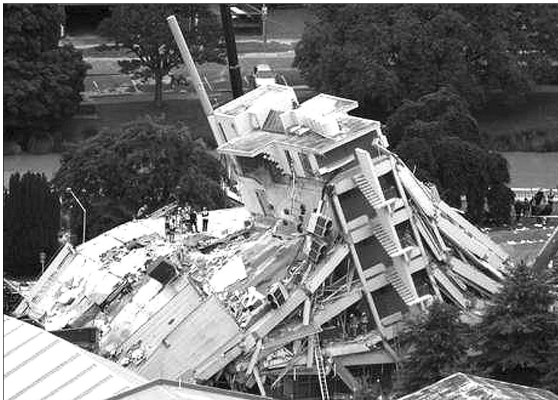
Épületek dőltek össze, utak rongálódtak meg Christchurchben. Az új-zélandi földrengés erőssége 6,3 fokozatú volt
