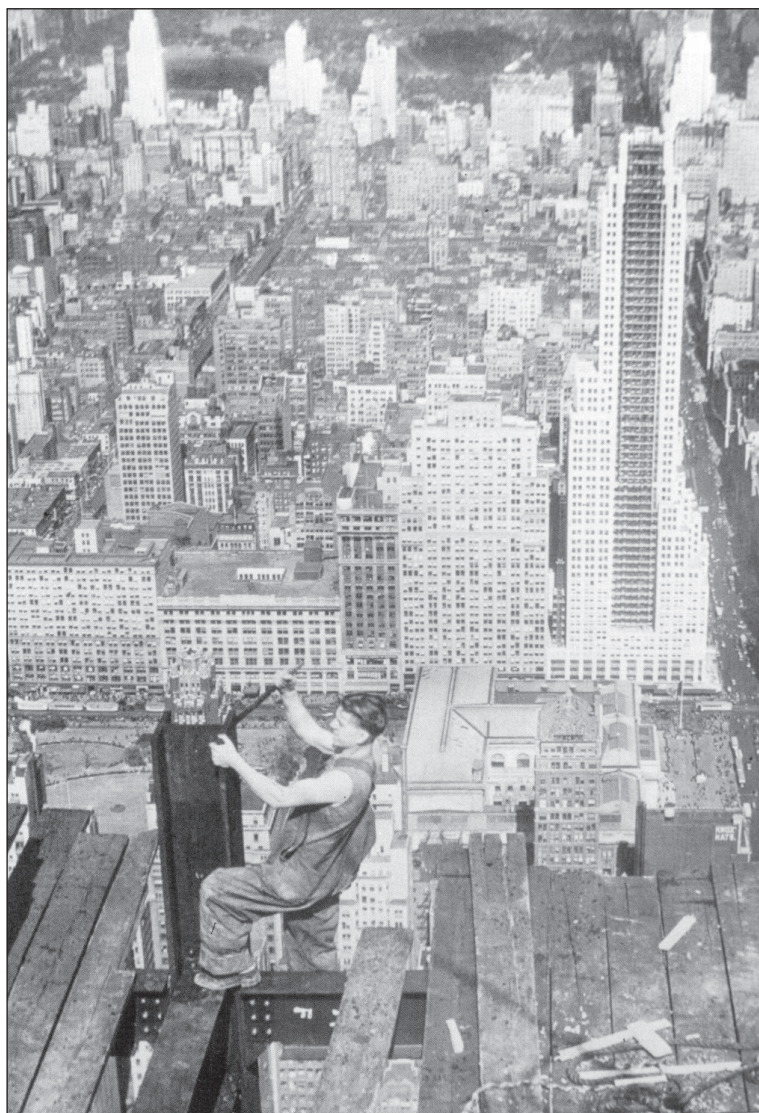
Munkás az épületszerkezeten az Empire State Building építkezésén, 1931
