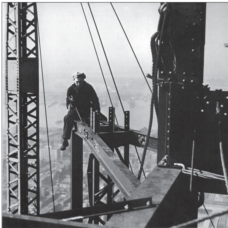
Munkás fogóval az Empire State Building építkezésén, 1931
