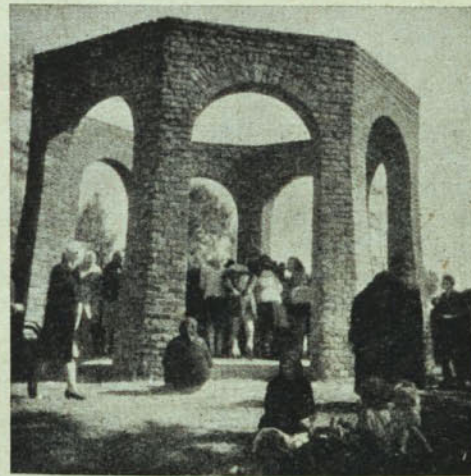
Az épülő szentkút, Pálosszentkúton.
