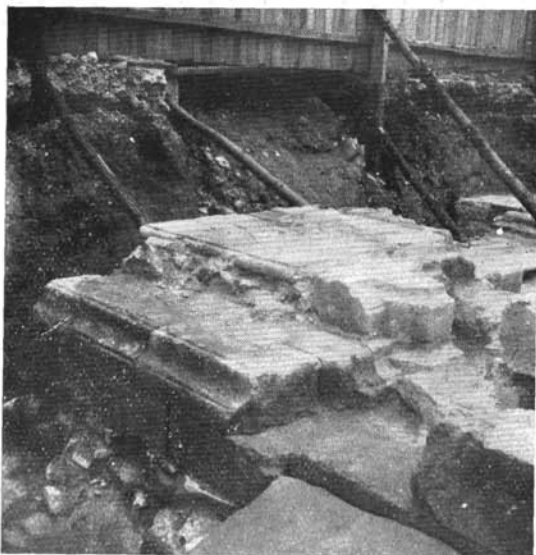
5. kép. Az 1. sz. pillér oldalnézete.
