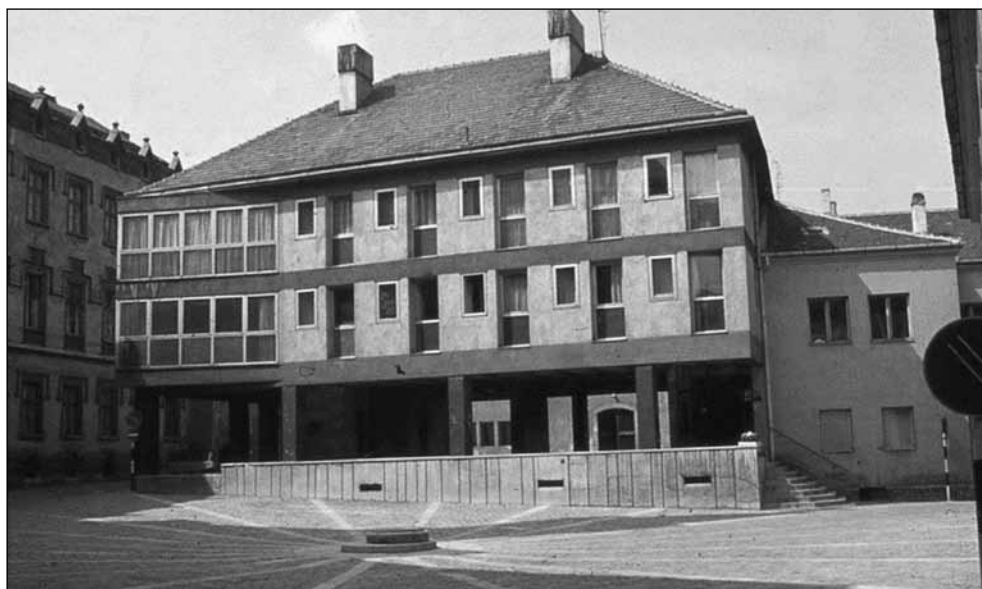
7. kép. Orsolya tér 4. Műteremházból parókia. Építész: Erdeős László, 1963-65. Forrás: https://sopronanno.hu/bejegyzes/az-orsolya-ter-4-a-labashaz-felol
