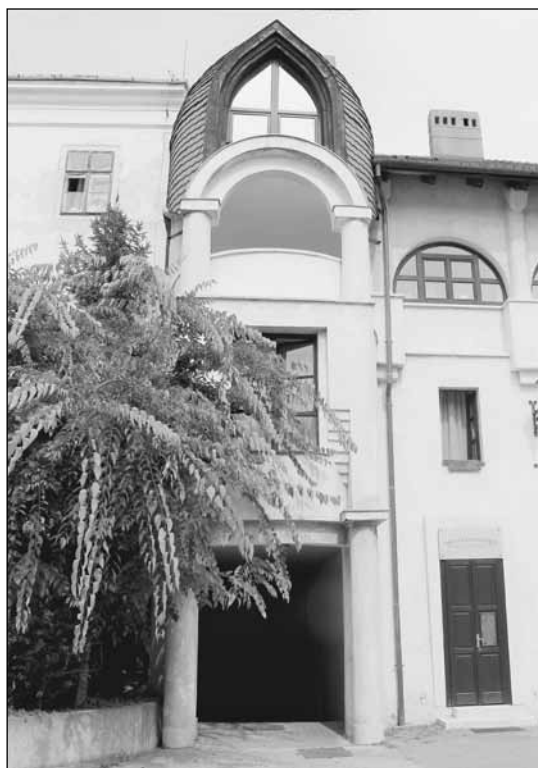
25. kép. Móricz Zsigmond utca – Ötvös utca közti tömb, irodákkal kiegészített lakóépület, udvari homlokzat. Építész: Kravár Ágnes, 1986-87.
