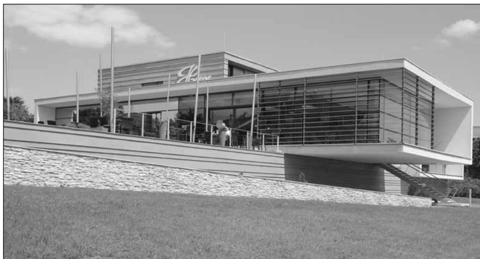
2. kép. Harrer csokoládéüzem, Faller Jenő u. 4. Építész: Christoph Huber, helyi építész: Kiss Gábor Árpád. Építés éve: 2008/2009., Winkler Oszkár-díj: 2010. Bolodár Zoltán felvétele
