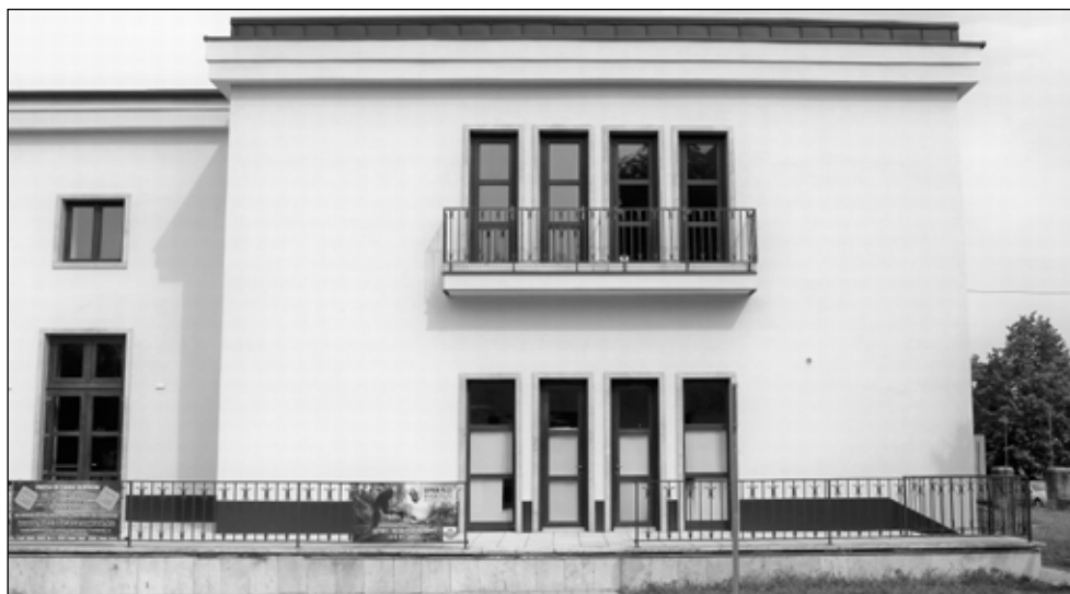
2. kép. SOTEX-kultúrház, nyugati homlokzat. Építész: Winkler Oszkár (GYTV Soproni Tervező iroda), belsőépítész: Németh István, kerámiák: Búza Barna szobrászművész, 1951-52.
