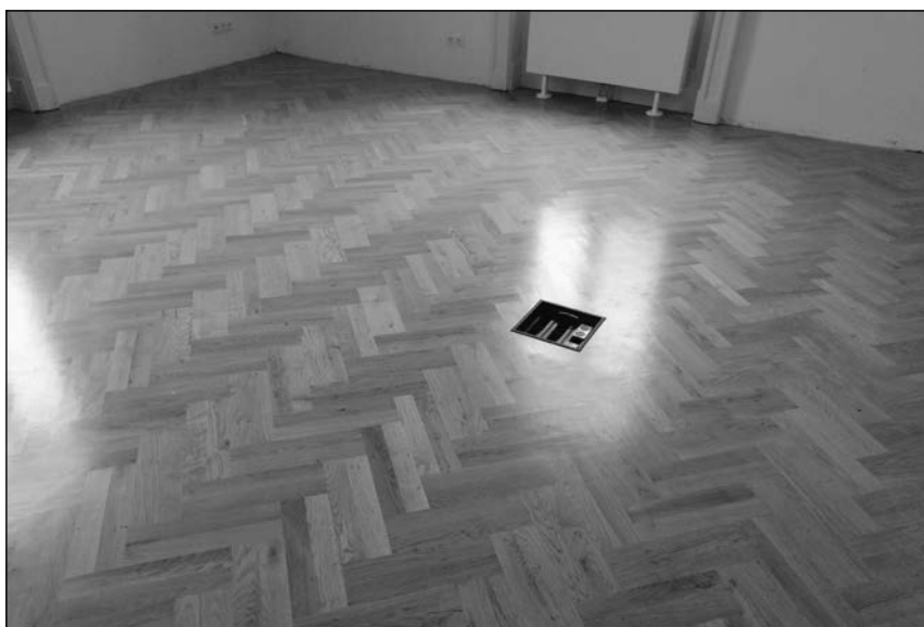
11. kép. Az új csaphornyos parketta, alatta az elrejtett gépészeti, erős és gyengeáramú vezetékekkel
