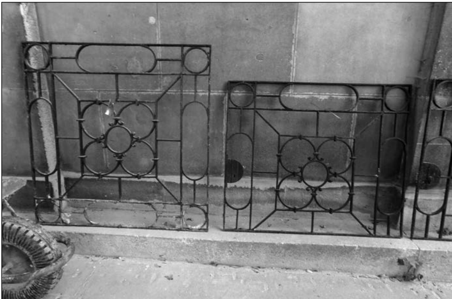
9. kép. A baloldali rács alja a járda betonjában volt, a jobboldali alját le kellett vágni, mert nyitható volt
