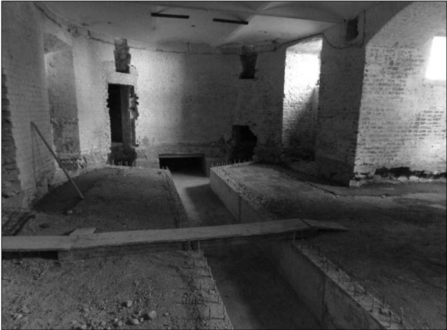
8. kép. Készülő légszatórna aknák a volt konyha padlója alatt
