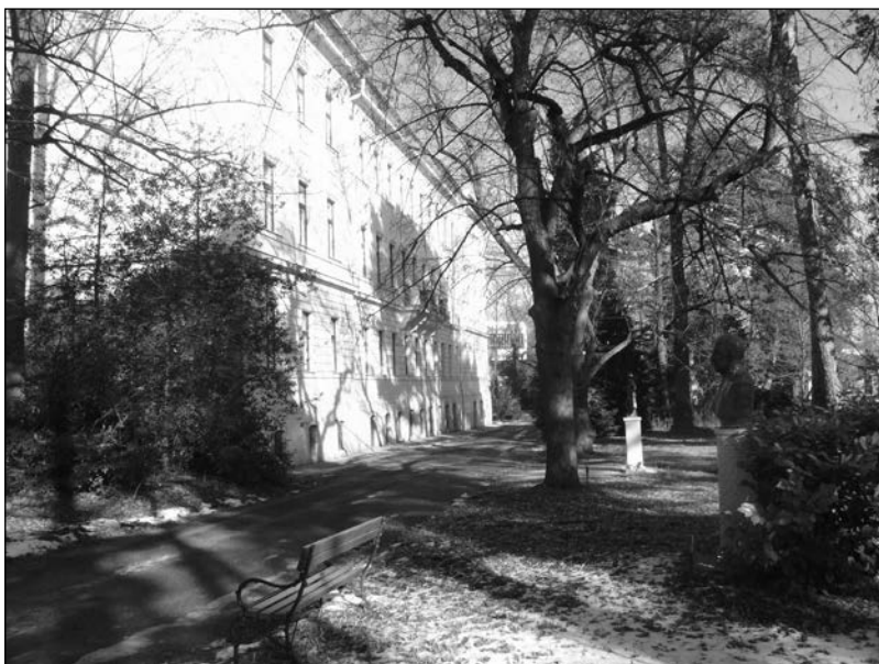
1. kép. A Hotel Inter egykori épülete, ma SOE Erdőmérnöki Kar Dékáni épület (Illyés, 2011)
