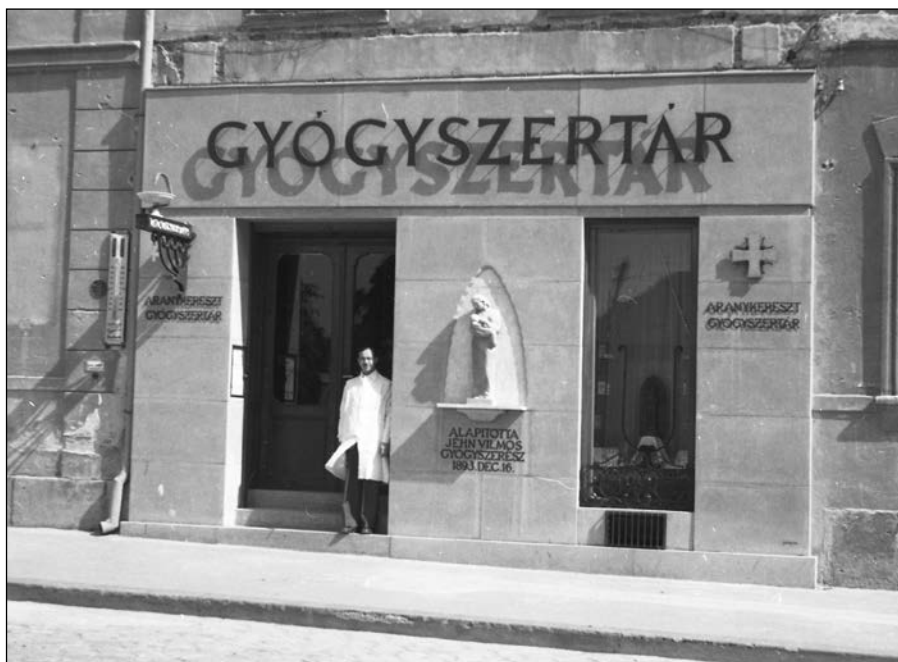
11. kép. Elkészült a modern portál Fotó: Diebold Károly, 1946. Soproni Múzeum, Fotótár, Lelt. sz.: 20950)
