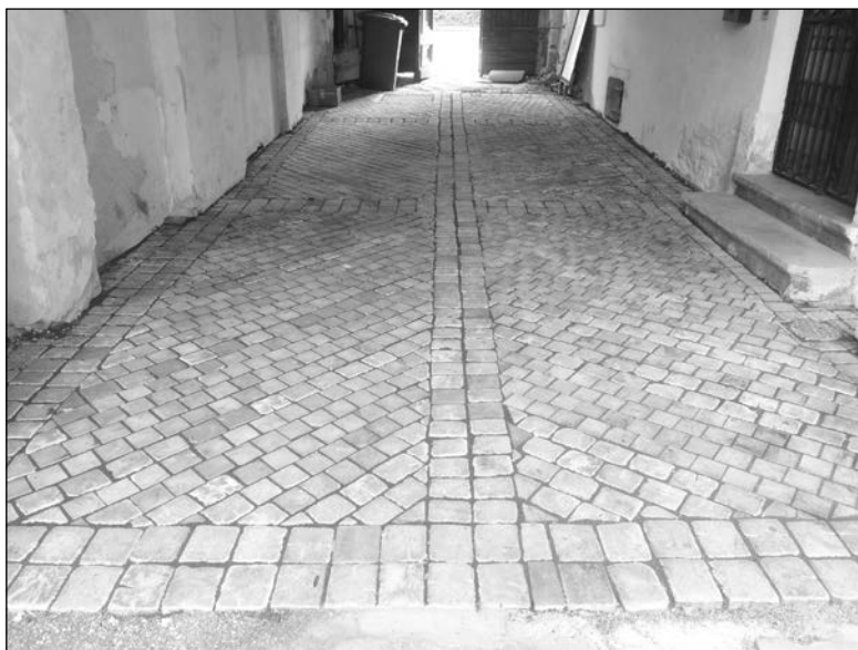
7. kép: Műemléki szempontú helyreállításon átesett fakocka burkolat egy kapualjban (a szerző felvétele)
