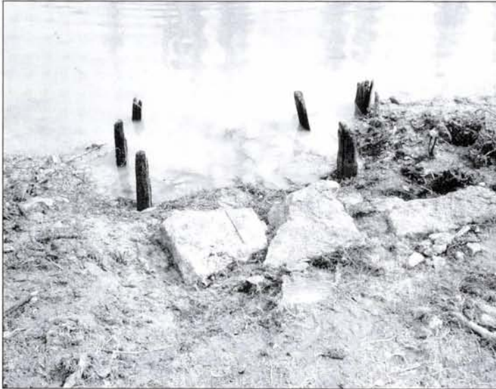
3. kép: A cölöpök és a köztük lévő mészkőtömbök alacsony vízállásnál (Gryneus András felvétele)
